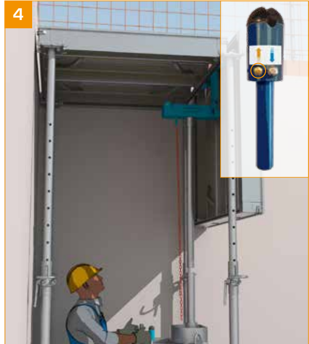
4 - Heben Sie das Paneel auf die gewünschte Höhe an: die Oberkante muss mit der Oberseite des bereits installierten Paneels bündig abschließen.
