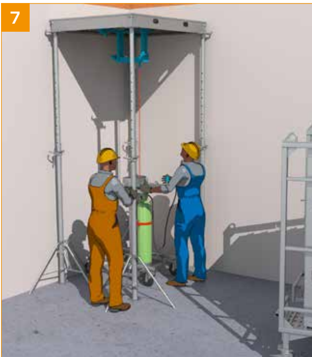
7 - Platzieren Sie die 4 Stützen jeweils mit Dreibein an den 4 Ecken des Paneels.
